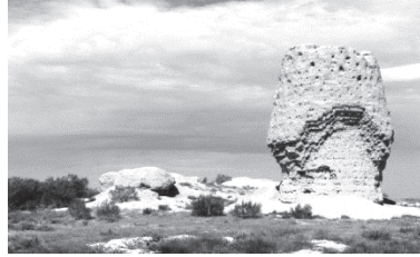
Foto. 6: Ak Kesene, güney yönünden görünüşü, ayrıntı, 2006.
